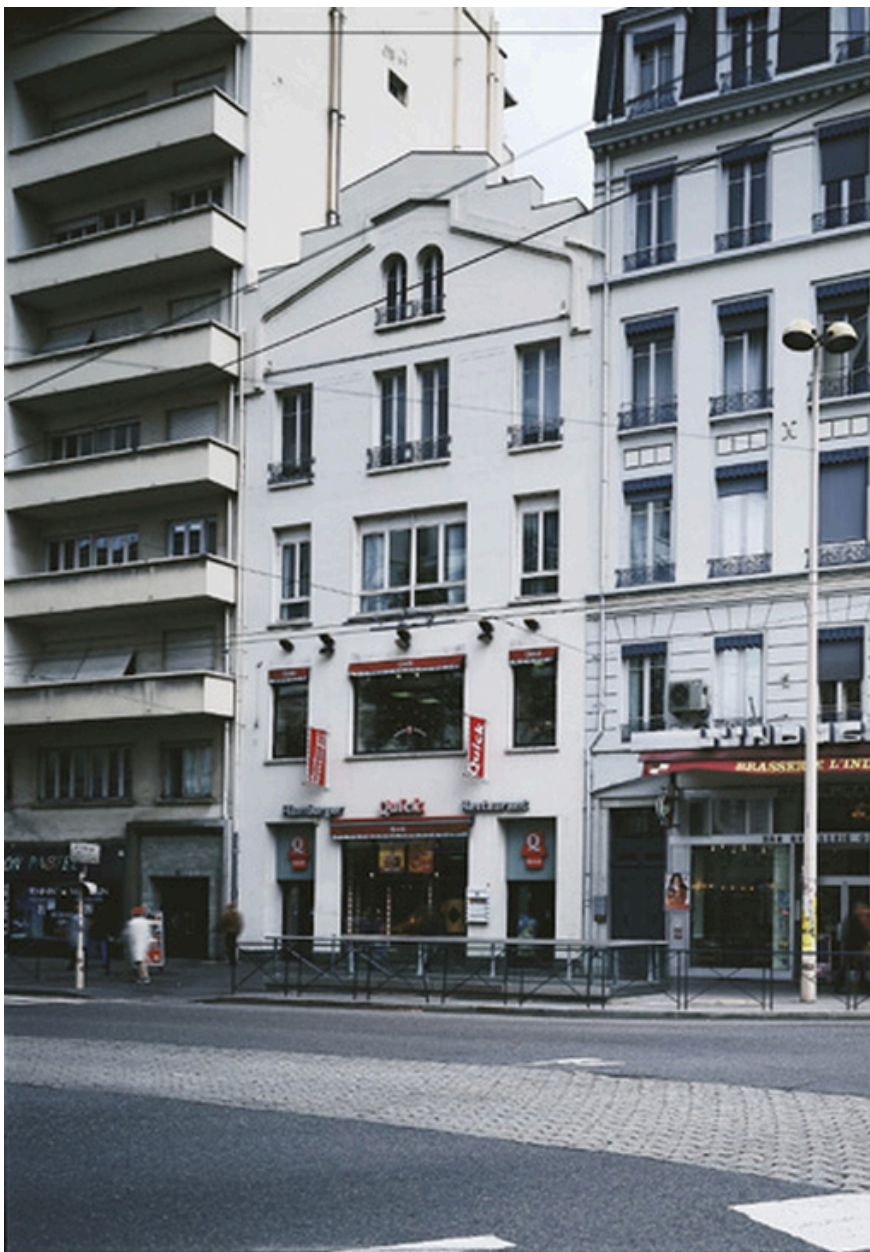
Vue d'ensemble ouest
