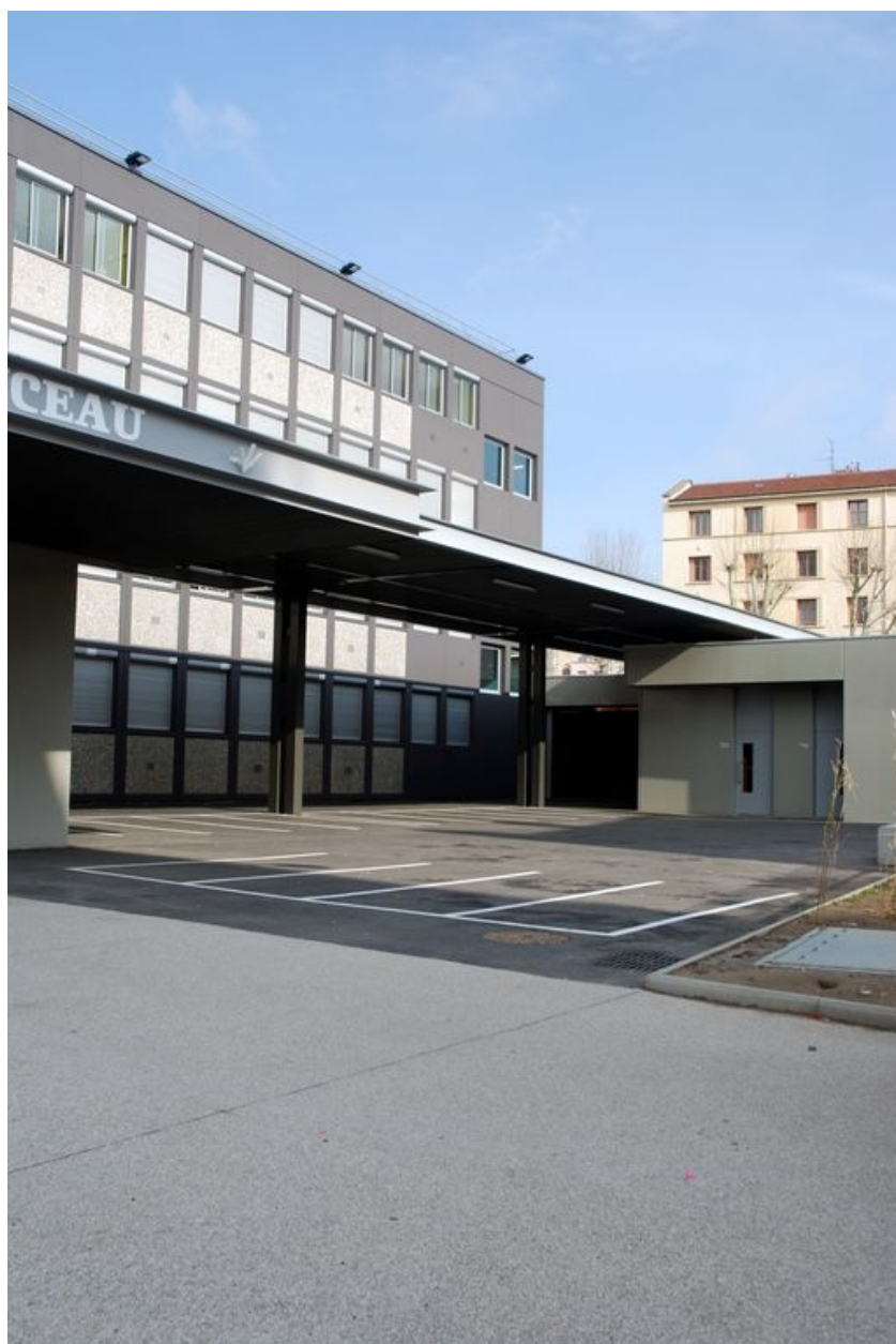
Détail de l'accès à la cafétéria.
