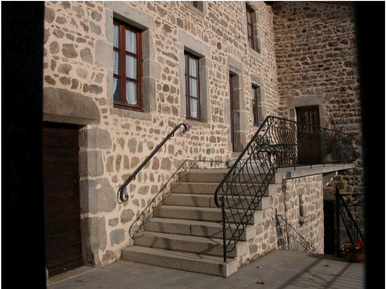
Vue du logis, depuis le portail de la cour.
