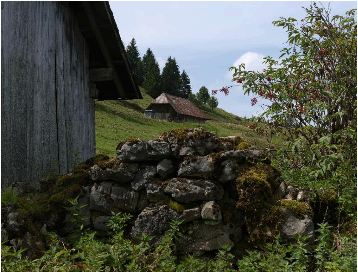
Vue générale depuis les vestiges de chalet 2013 D2 251 (non repéré).
