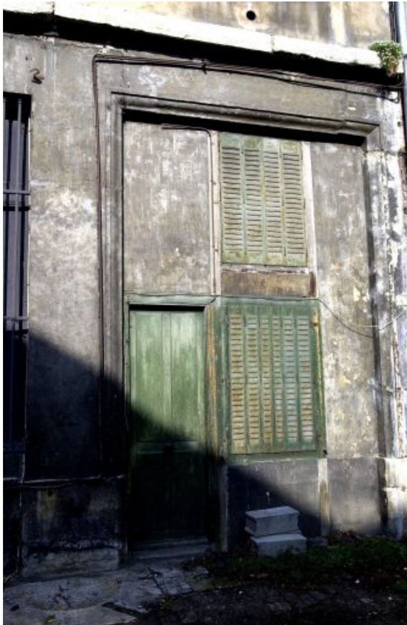
Elévation de la conciergerie sur la cour
