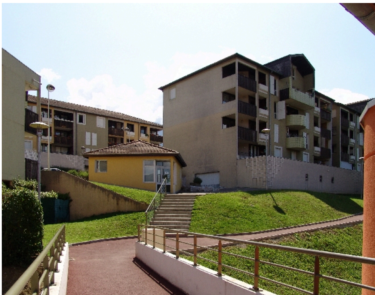
Vue prise du nord-ouest
