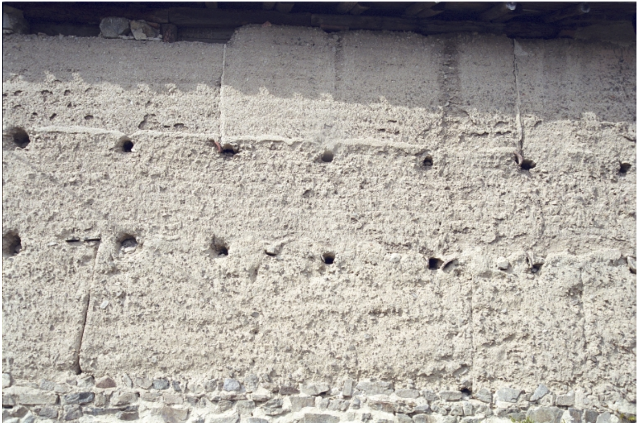
Saint-Sixte, le bourg, ferme (1987 A1 85). Élévation postérieure, détail (milieu 19e siècle).
