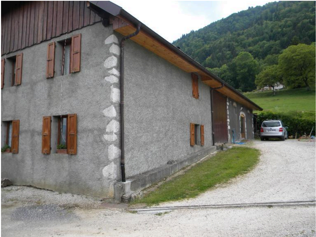
Vue de la façade arrière de l'ancienne ferme.
