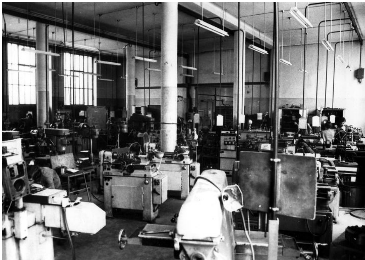
Atelier sud du collège d'enseignement technique (construit en 1958), 1975
