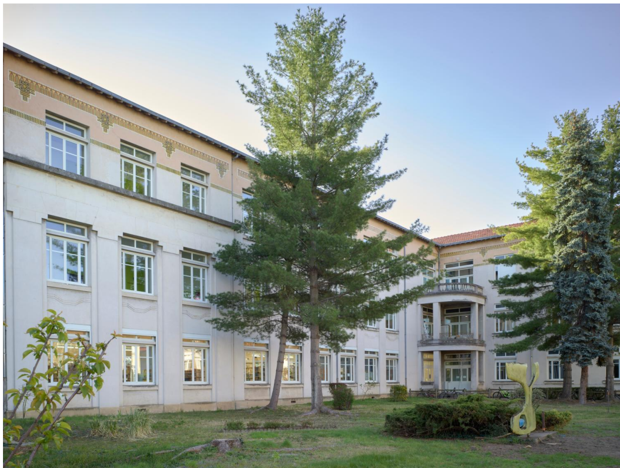
Vue générale, dans son environnement.
