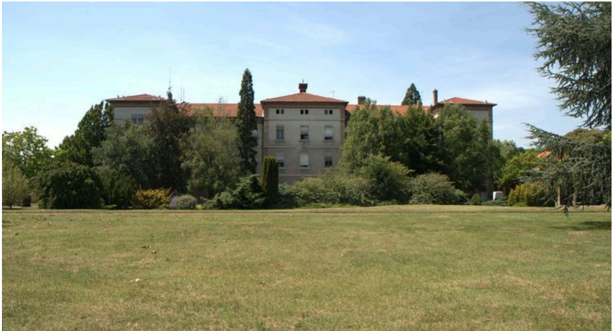
Vue de l'actuelle façade principale du bâtiment des services généraux, depuis l'est
