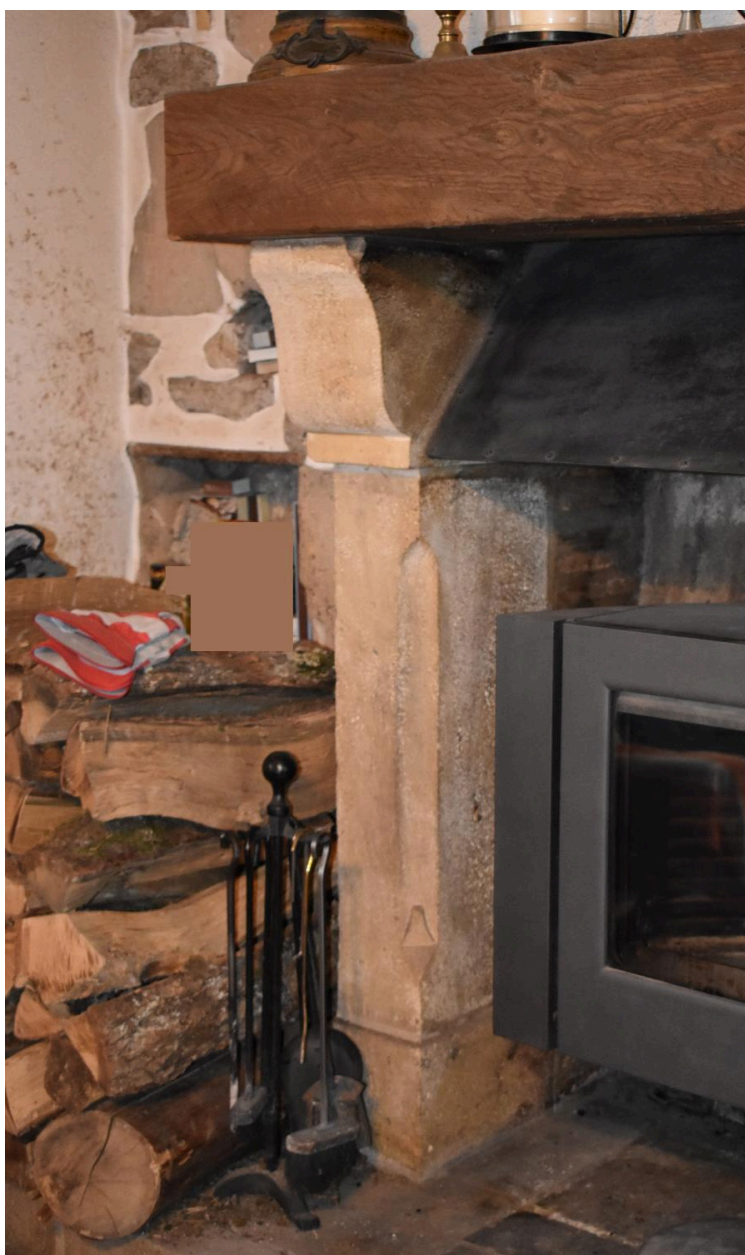
Détail de la cheminée de la maison, n°8, rue de Bourbon : parcelle cadastrale B01 : 151.
