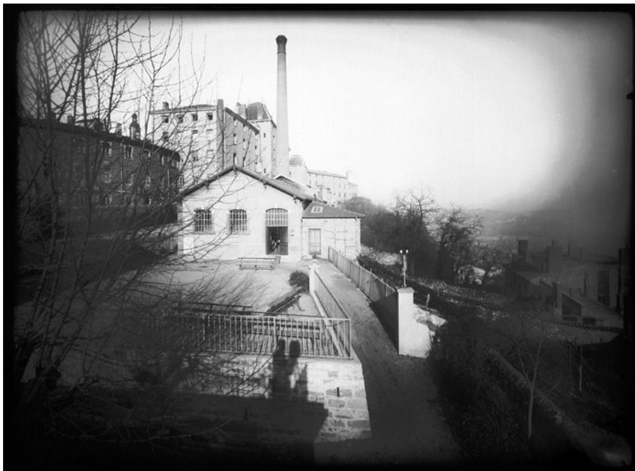
Vue de la chaufferie générale, fotogr. par l'abbé Amphoux, ca 1920-1930
