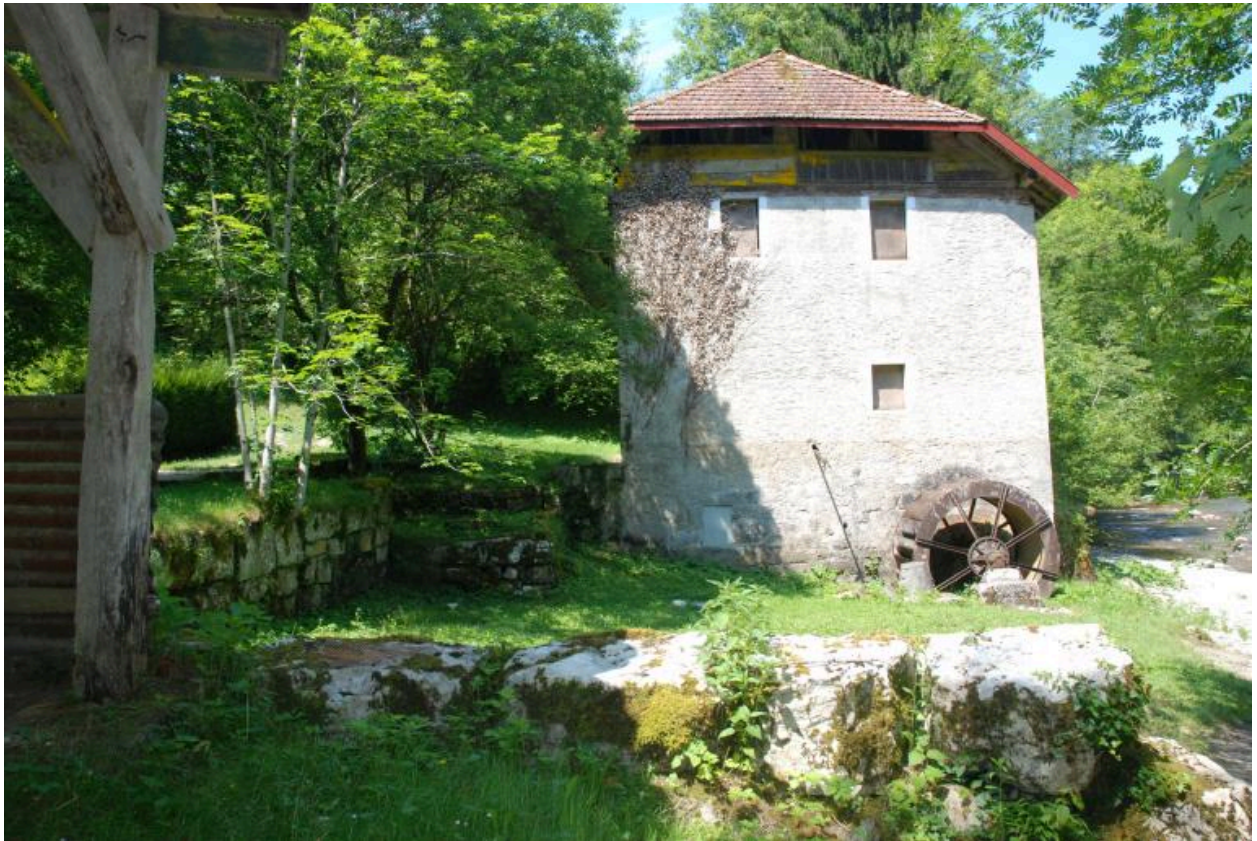
Vue du bâtiment principal, élévation est.
