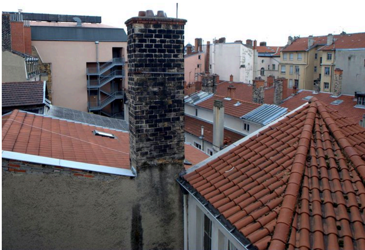
Vue de la partie est du coeur de l'îlot, depuis l'ouest
