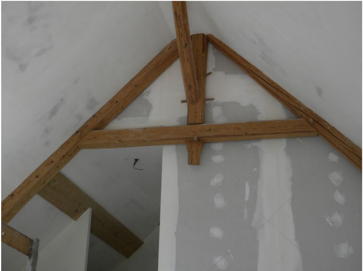
Détail de charpente dans une ancienne ferme remaniée (2008 A3 3547).
