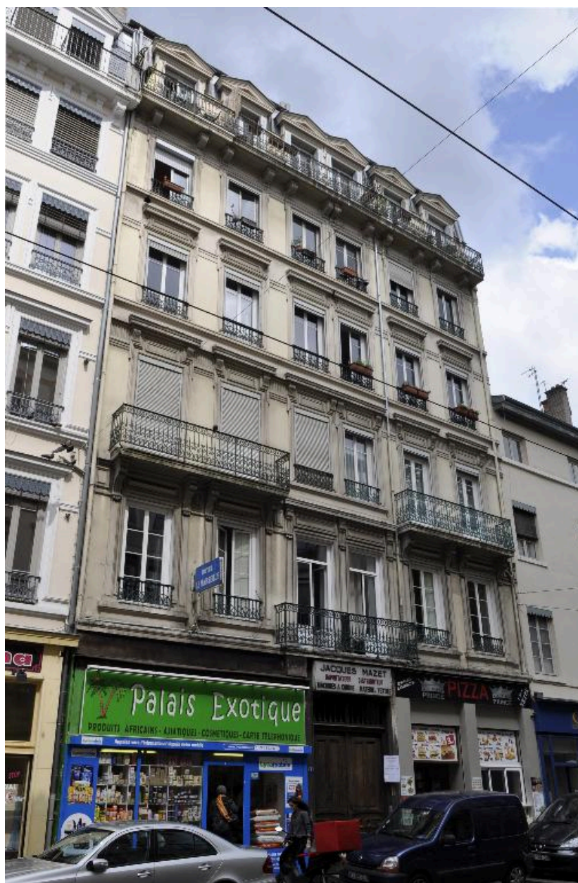
Vue générale de l'élévation sur rue
