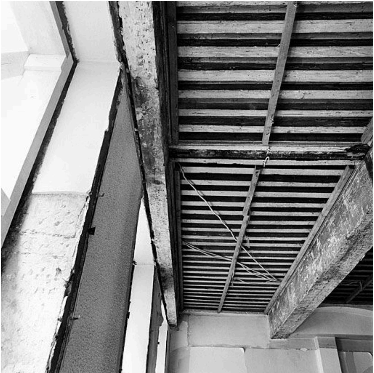
Corps sur la rue Mulet, plancher entre le 2e et 3e étage
