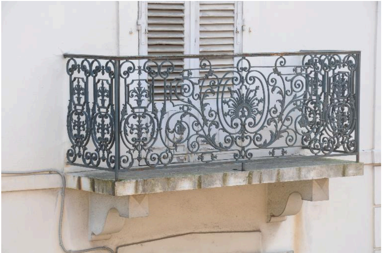
Balcon au 2nd étage
