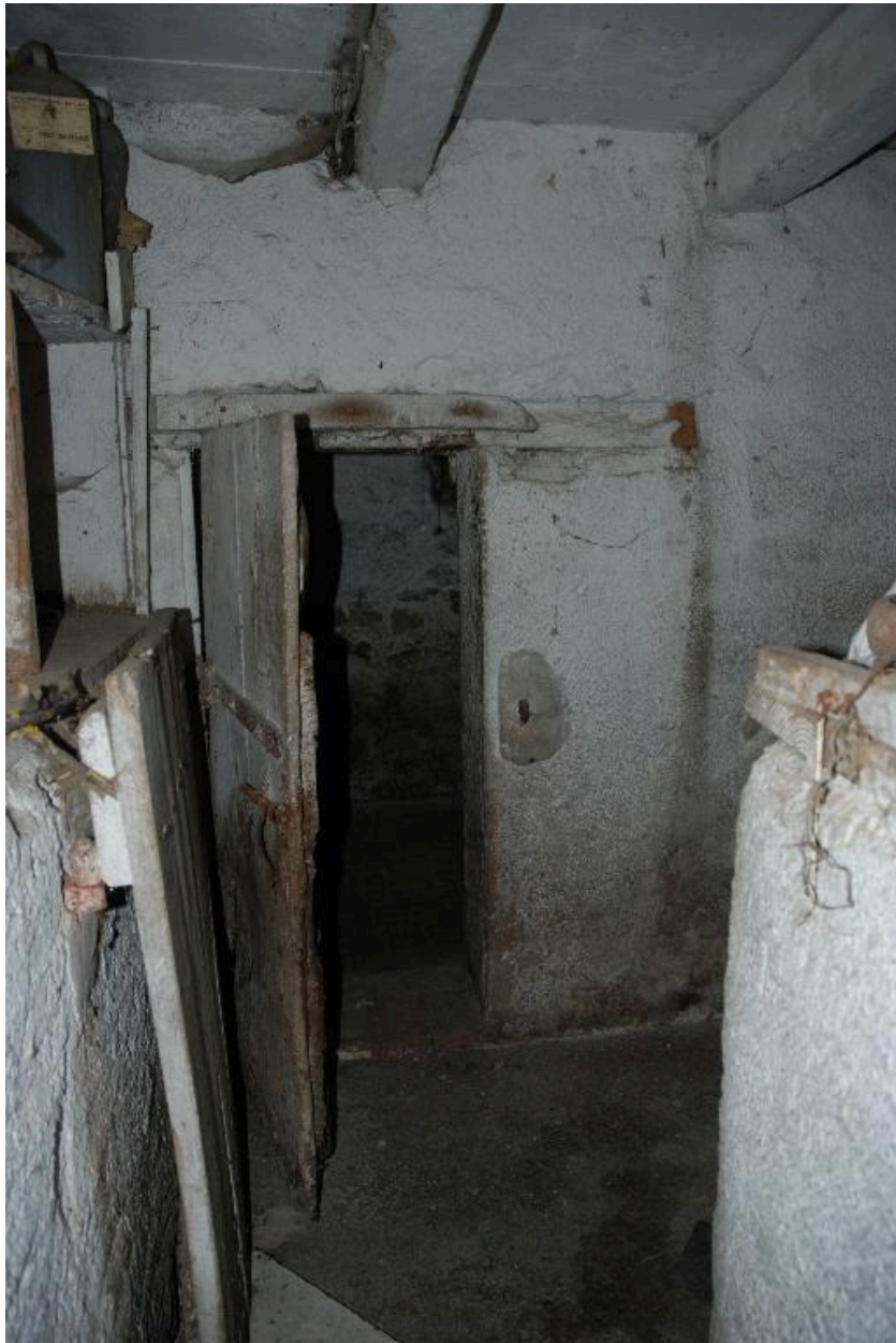
Vue de l'entrée de la loge à cochon.
