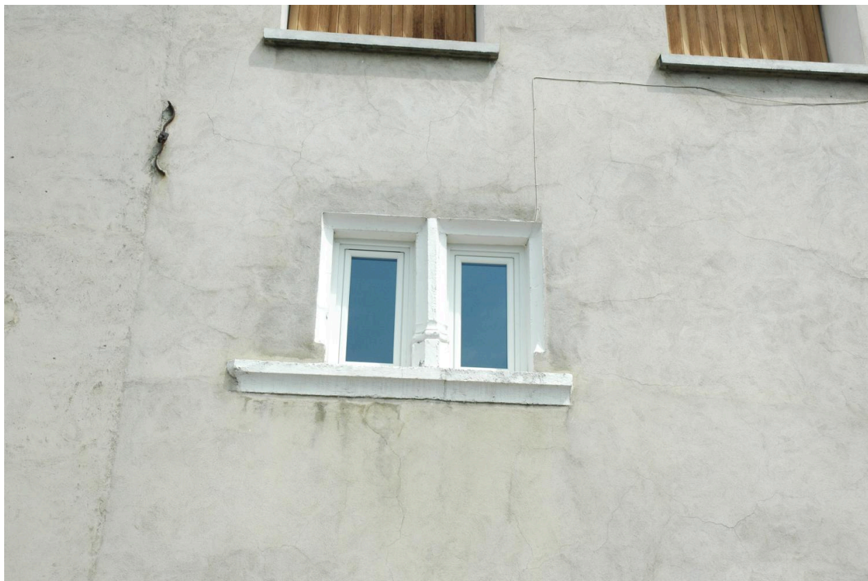
Détail de fenêtre à meneau, à encadrement à chanfrein et congés (2018 B 427).
