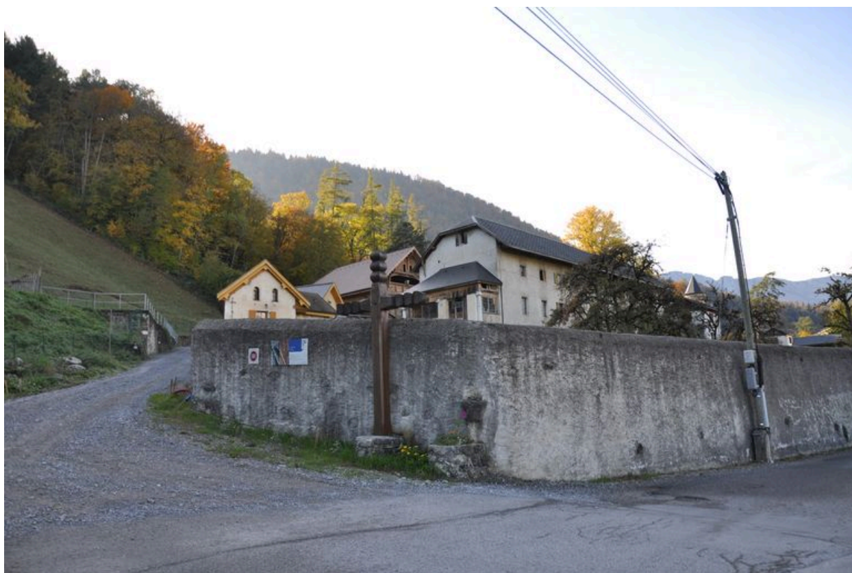
Mur de clôture du château de Giez donnant sur la route du Thovey
