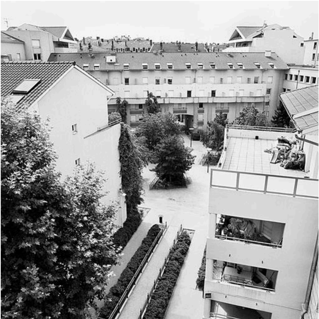
Vue générale du cœur de l'îlot. Passage vers l'entrée de l'école depuis le square
