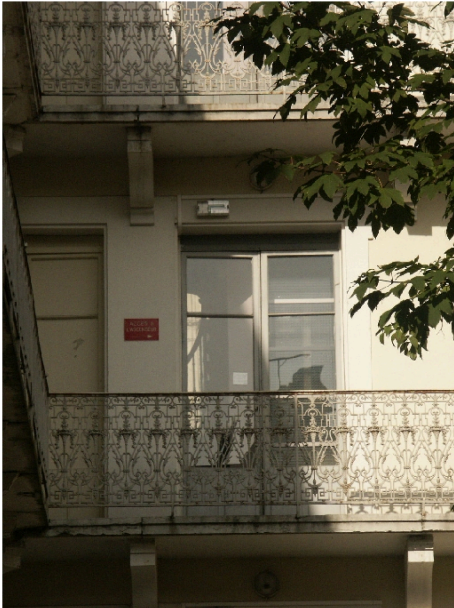
Aile nord : balcons sur jardin
