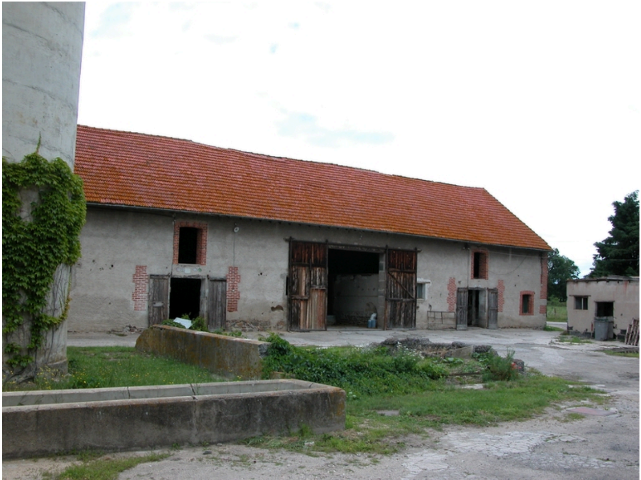
Vue du côté nord de la cour : granges-étables.
