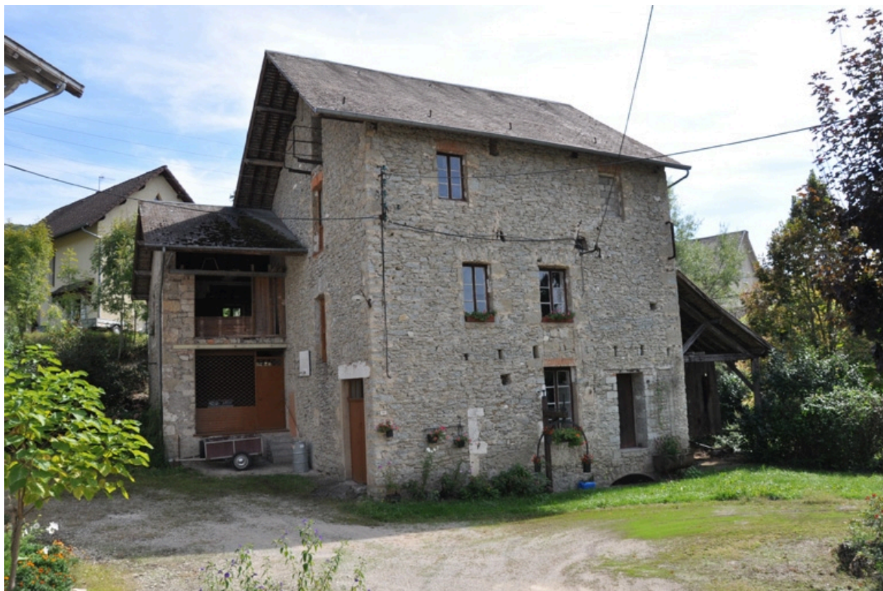
Façade nord-ouest et nord
