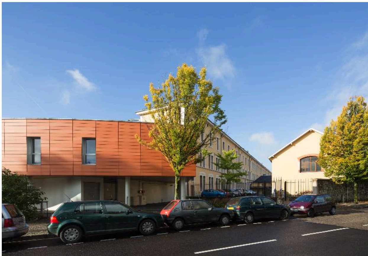
Angle boulevard Nicollet/boulevard Taine : entrée du personnel et gymnase.
