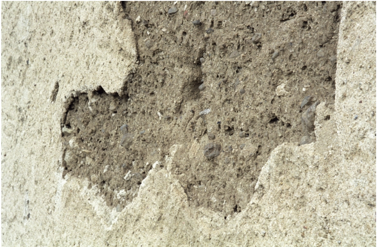
Cezay, Coton, ferme (1987 A4 992). Détail du mur en pisé et de l'enduit.
