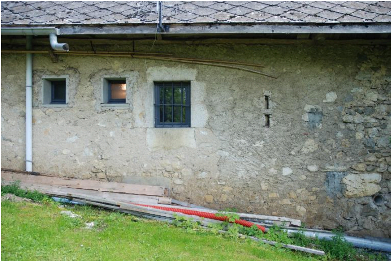
Détail des ouvertures en façade arrière (fenêtres, jours d'aération de placard).
