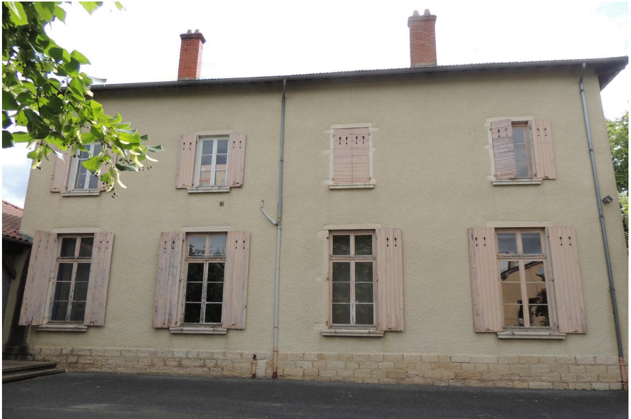
Façade sur cour.
