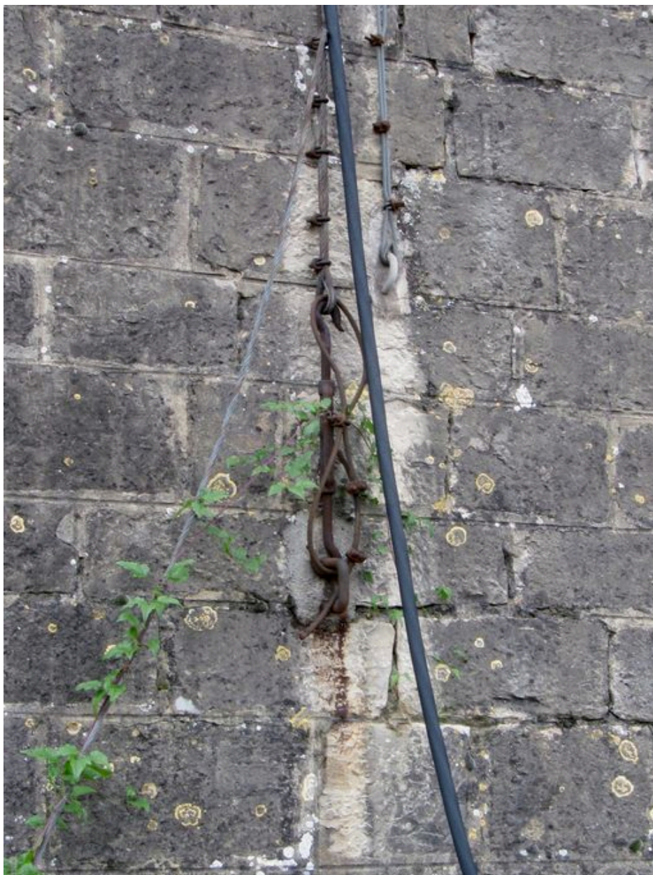
Pile droite, angle nord-ouest, vue de détail : ancrage du câble (depuis la rive droite)
