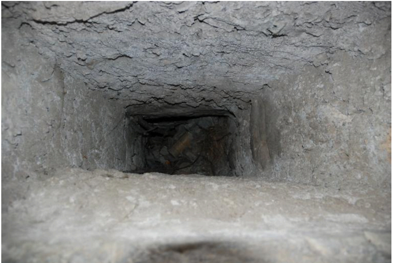
Corps de bâtiment est, intérieur du soupirail situé à droite de la porte d'accès à la cave.
