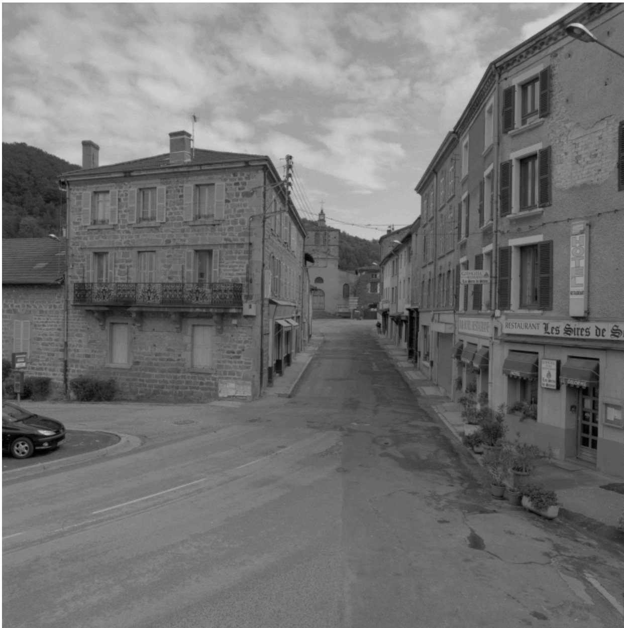
Vue d'ensemble de l'édifice de trois-quarts depuis la route.
