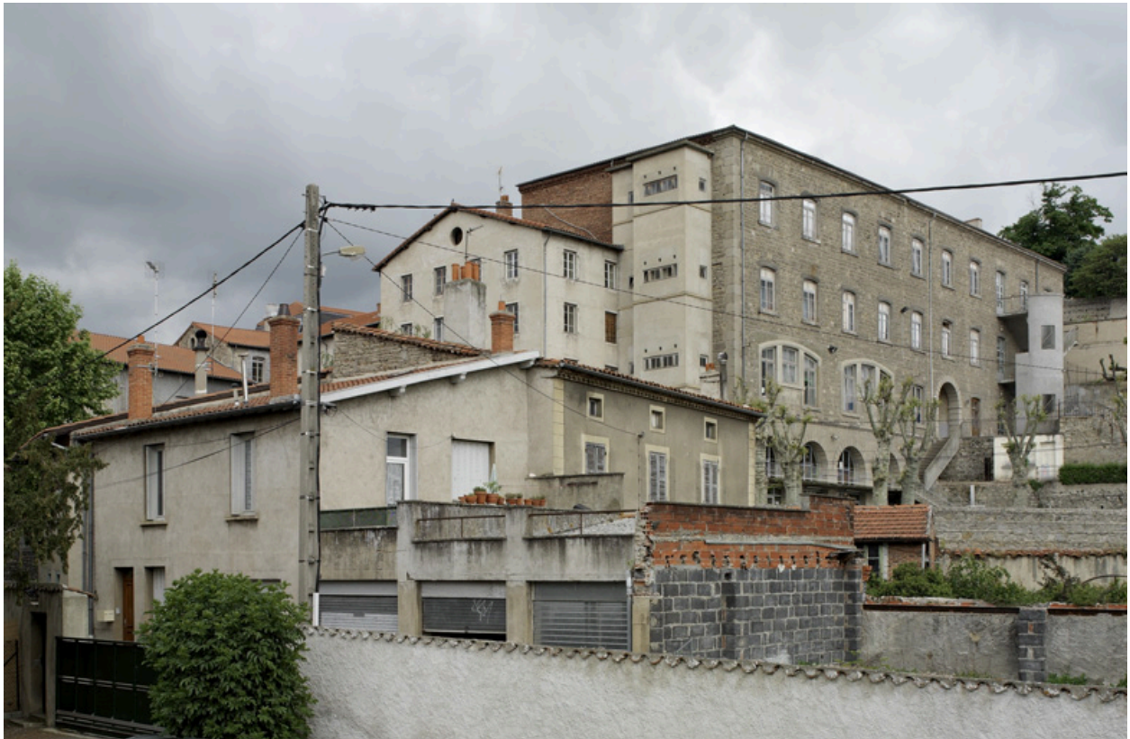
Vue générale des bâtiments D et C depuis la rue du Bout du Monde.
