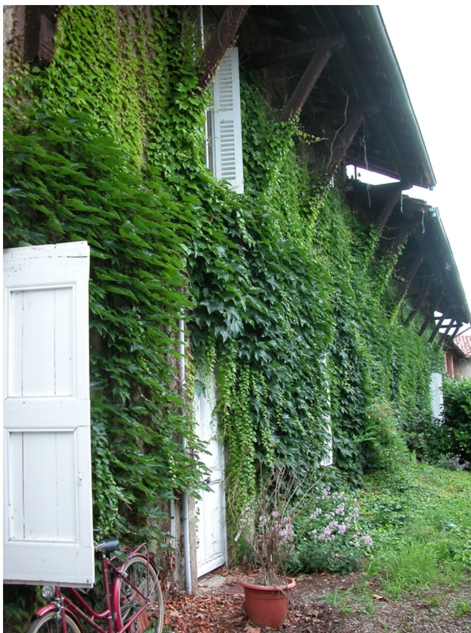
Vue latérale de la partie habitation depuis la cour, du sud.
