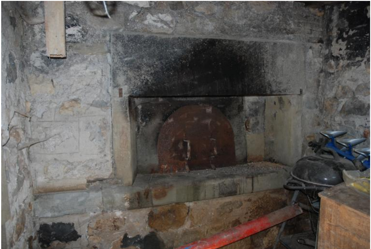
Vue intérieure du fournil.
