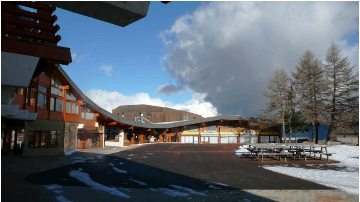
Vue depuis le sud
