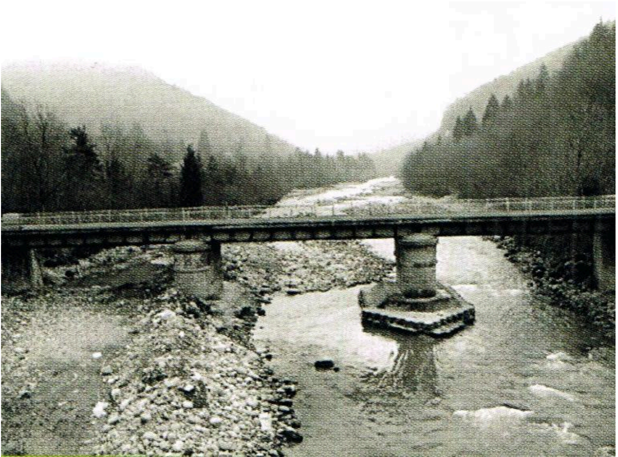
Ancien pont de la Douceur
