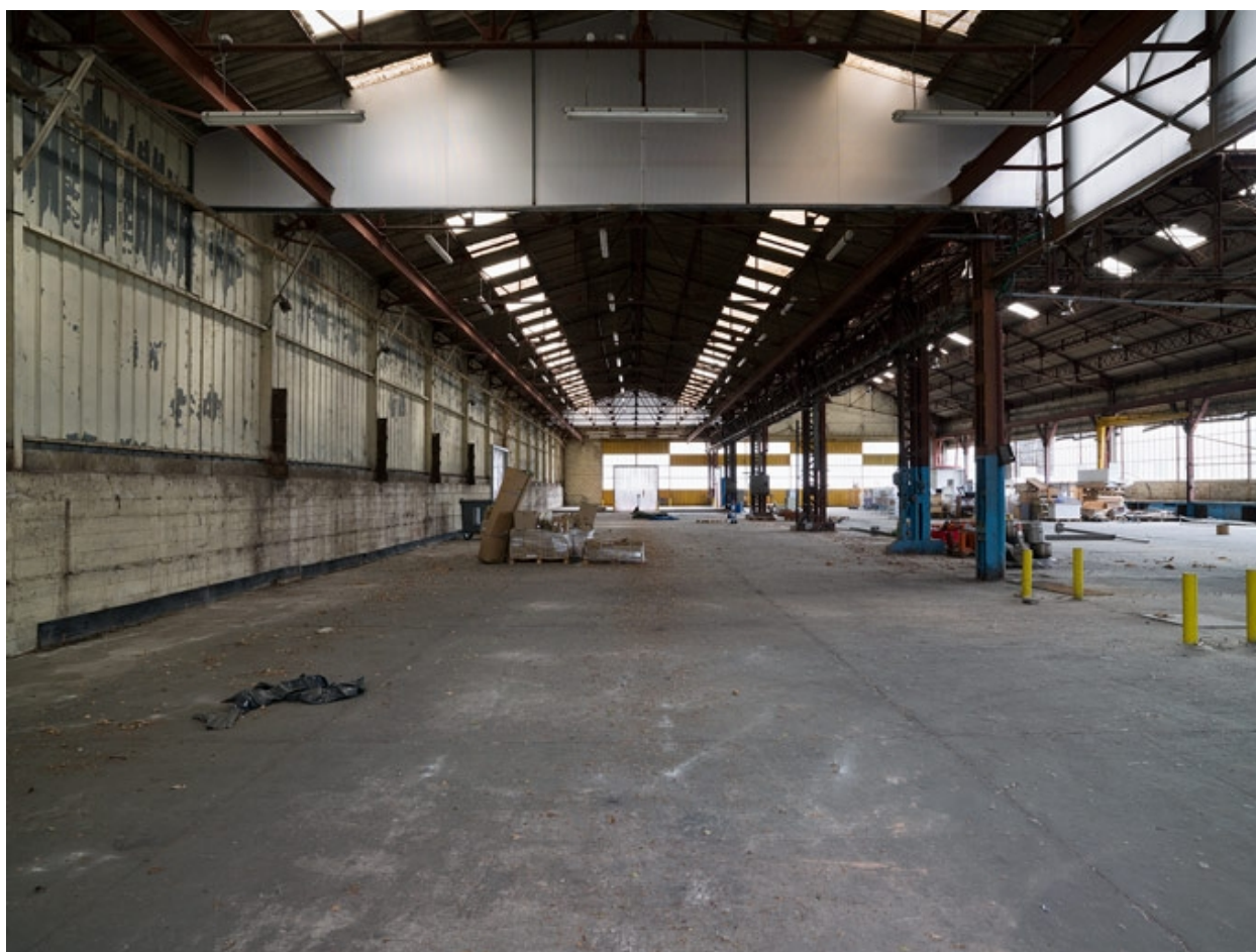
Vue d'ensemble intérieure des ateliers
