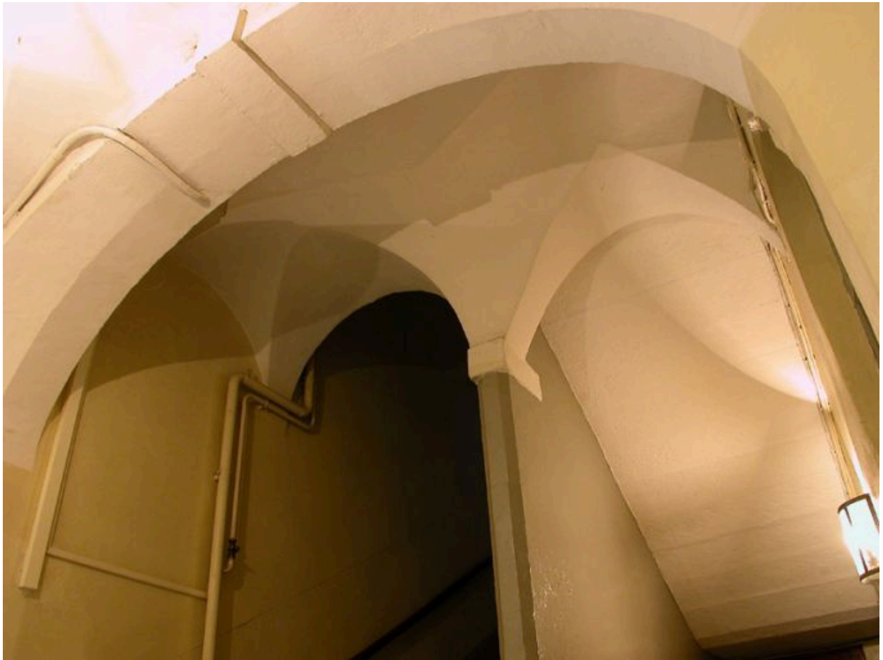
Escalier lié à l'entrée sur la place Meissonier, couverture du palier du rez-de-chaussée
