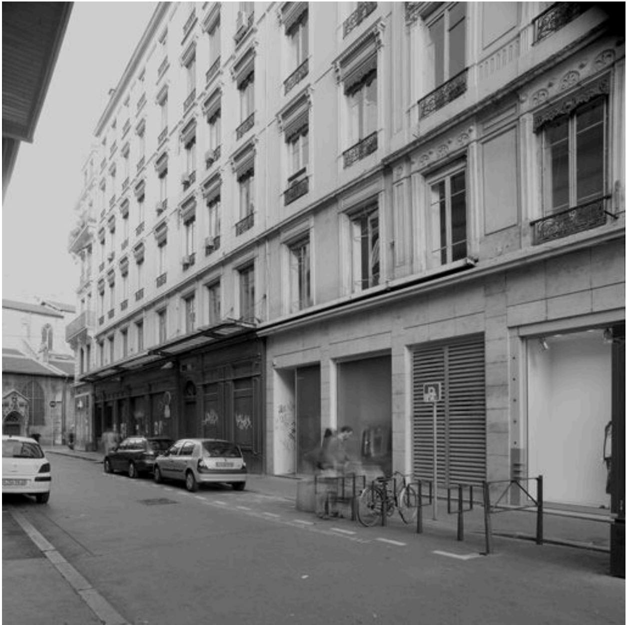
38 rue Tupin : vue d'ensemble du rez-de-chaussée depuis l'ouest
