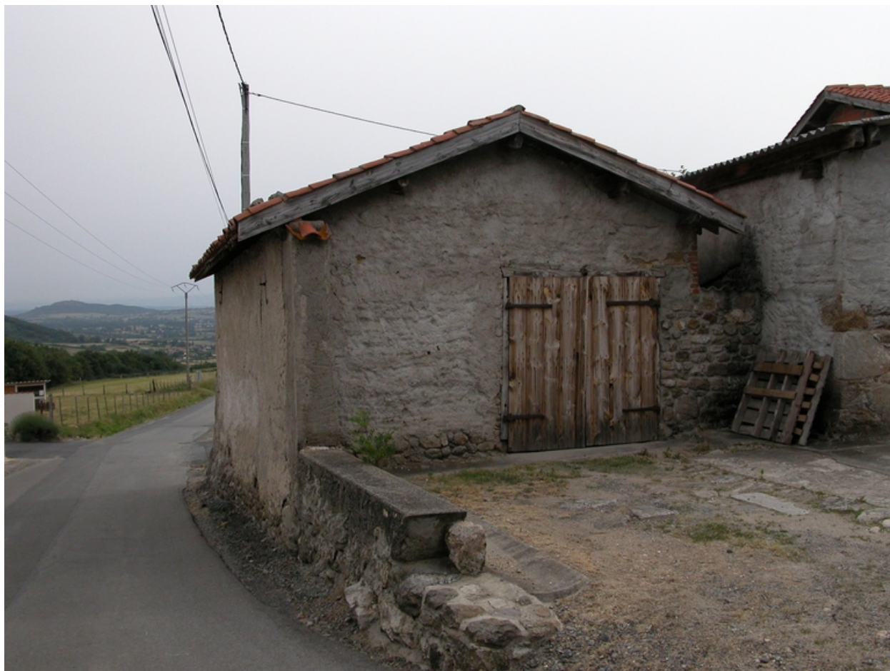
Vue du cuvage (1999 ZL 6) : entrée du cuvage.
