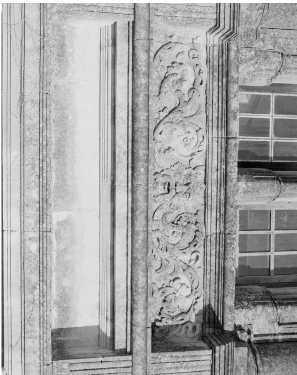
Cour du puits. Façade sud. Neuvième travée de la frise sculptée.
