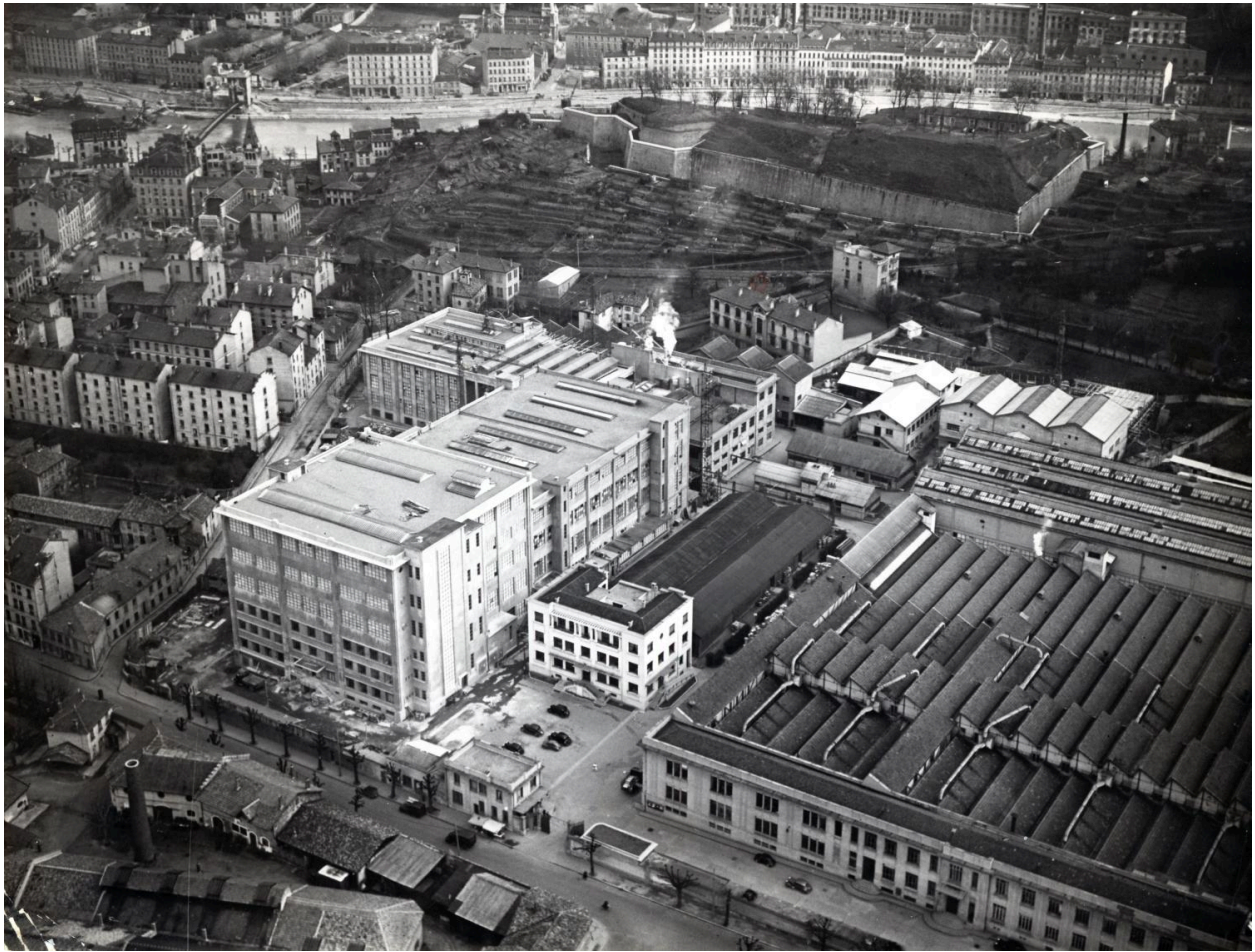
Vue aérienne de l'usine Rhodiaceta de Vaise 1970 (BML)
