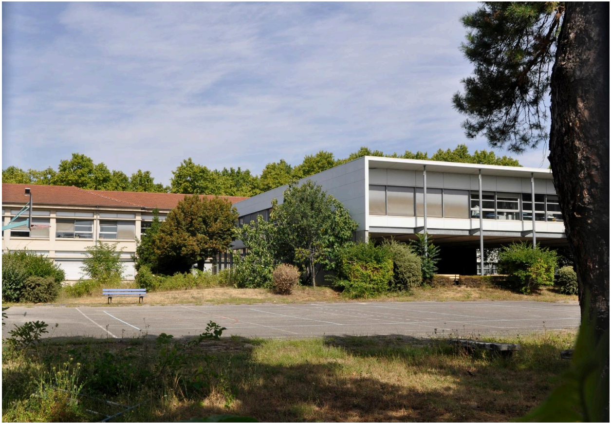
Elévations postérieures et terrain de sport
