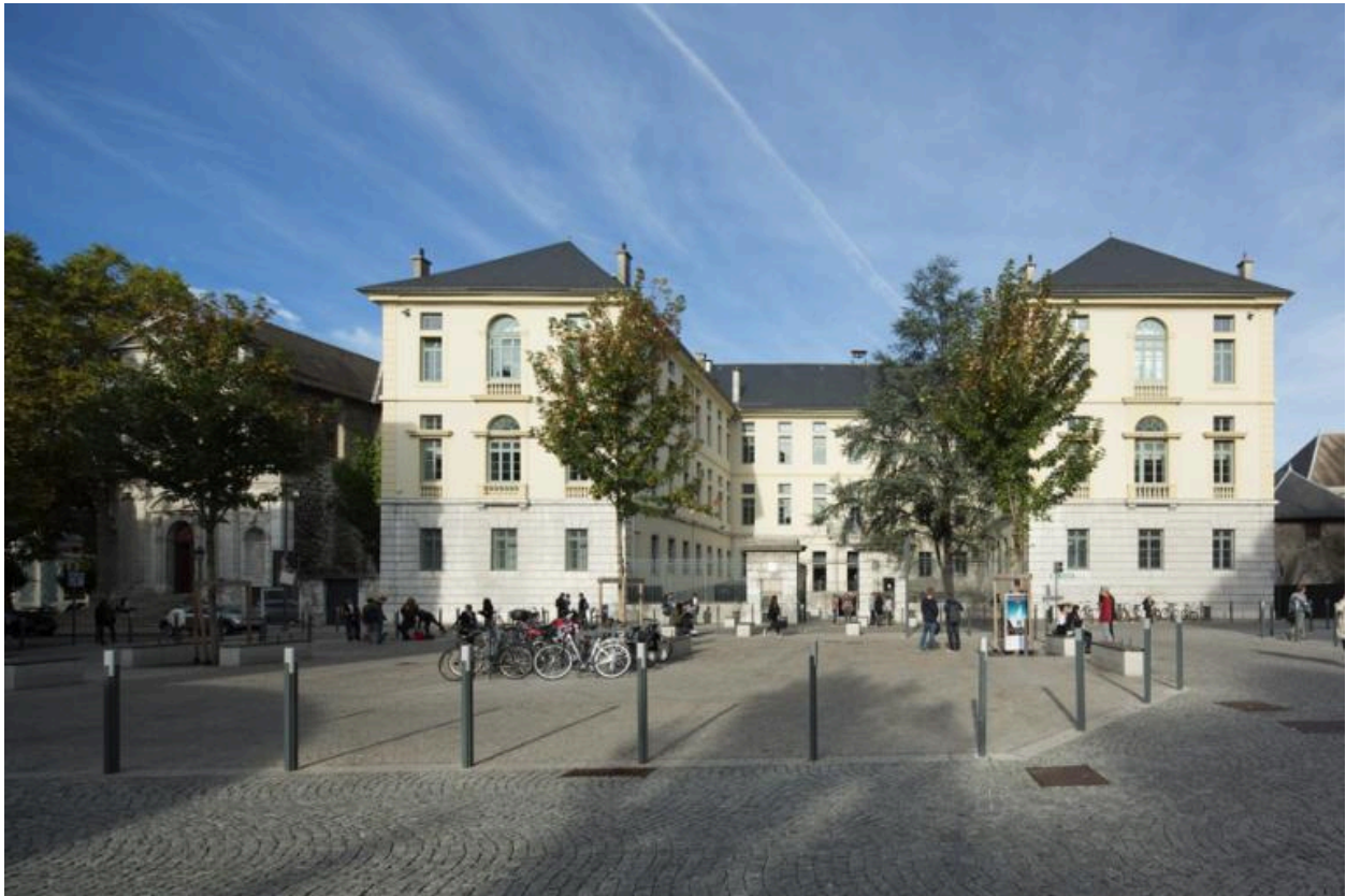
Bâtiment en H, vue d'ensemble depuis la rue.
