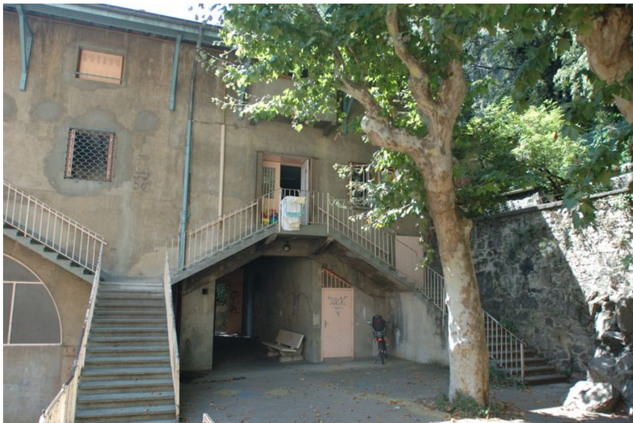
Vue de l'accès à la cour.
