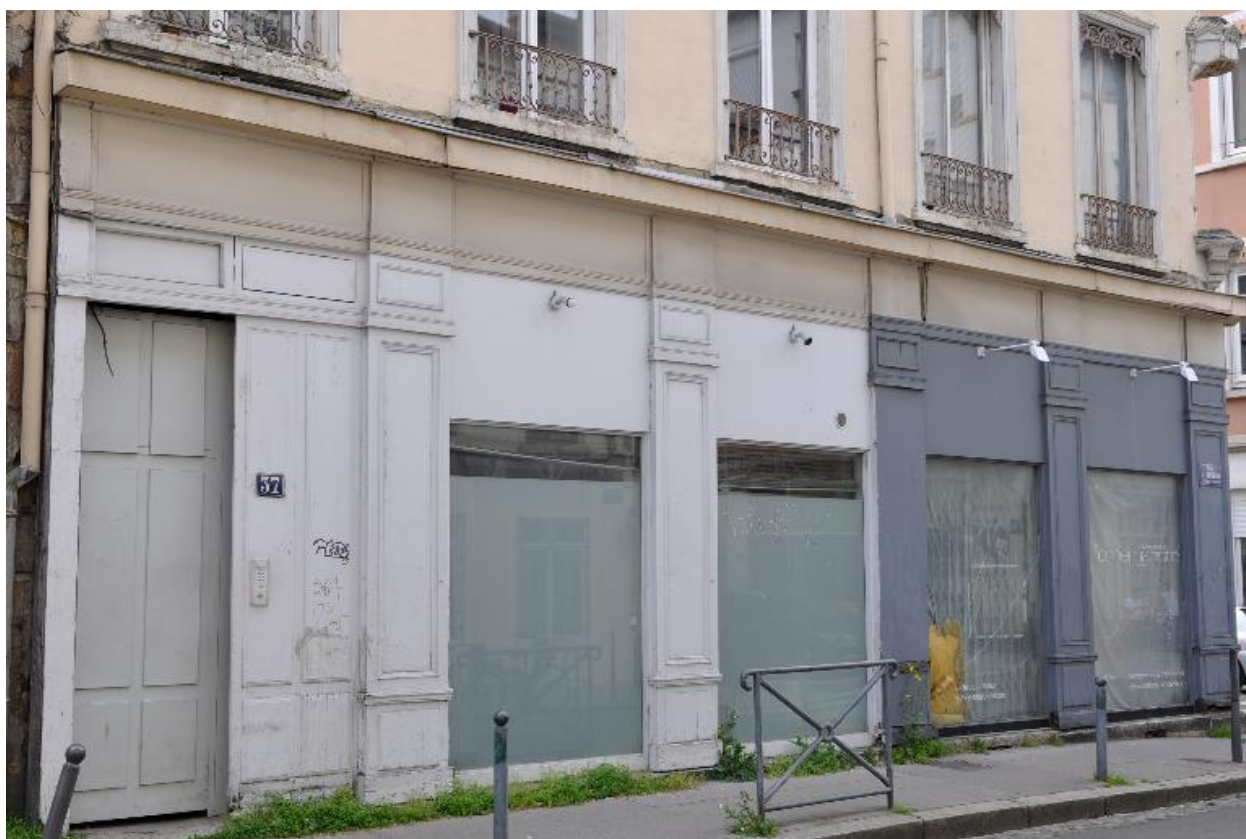
Détail du rez-de-chaussée, anciennes devantures en bois
