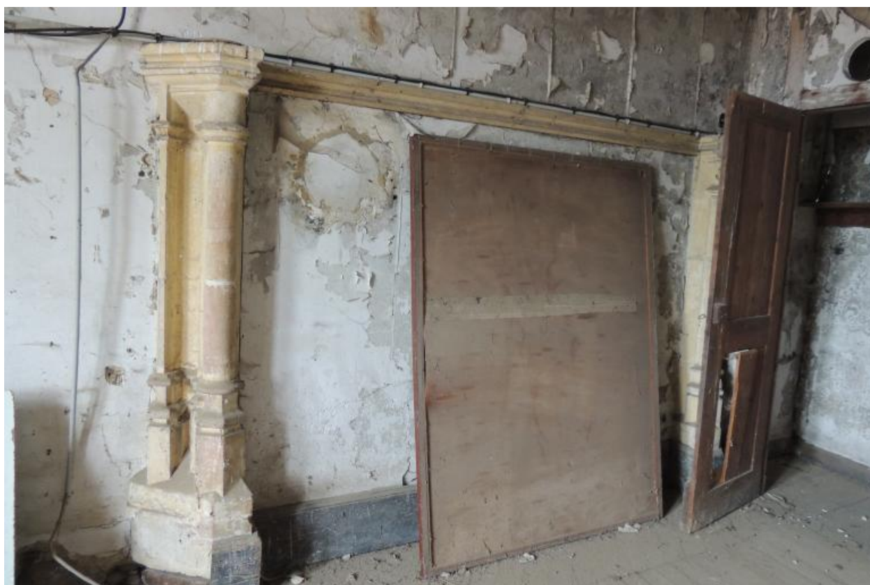
Étage noble, cheminée traversante, côté ouest.
