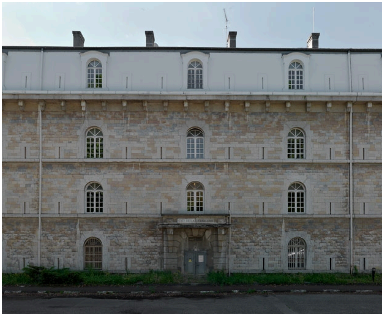
Façade nord ouest du bâtiment principal.
